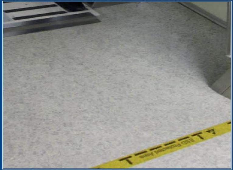
Pavimento vinílico disipativo electrostáticamente de 2mm de espesor en losetas de 608 x608mm o en rollos de 2m de ancho por 20m de largo.
